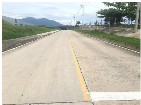
รูปที่ 17 การติดตั้งเครื่องหมายจราจรและการตีเส้นแบ่งจราจร
