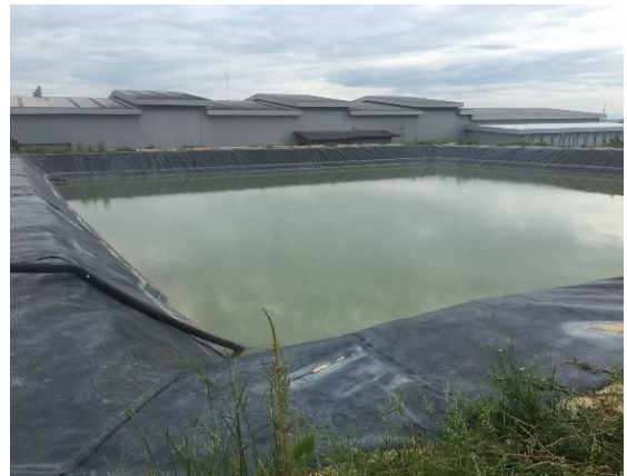
รูปที่ 11 การปู HDPE บริเวณบ่อพักน้ำทิ้ง
